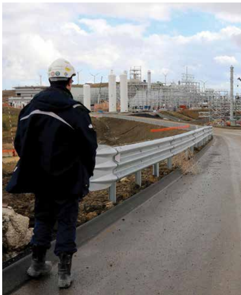
Sullo sfondo, il Centro oli in Val d'Agri di Viggiano (Pz)
